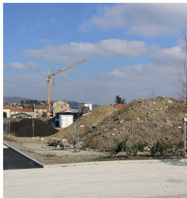
**Plateforme de bioremédiation des terres avant valorisation dans le cadre du réaménagement d'une ancienne friche industrielle.** © BRGM - P.Bataillard
