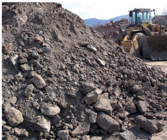
**Gravats issus de la déconstruction de bâtiment en attente de concassage et de criblage avant valorisation en sous-couche routière.** © BRGM - P.Bataillard
