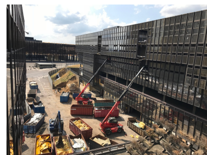
Déconstruction du bâtiment Jean Monnet. © Schroeder & Associés
